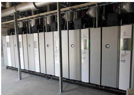
2014年度も、製造工程から出る排水・廃熱を回収して再利用する取り組みを精力的に進めました。たとえば、温排水を回収してボイラー向け給水として再利用することで、水やガスの使用量を削減でき、CO<sub>2</sub>排出量をさらに約60t-CO<sub>2</sub>減らすことができました。
