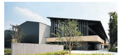
龟甲万中央研究所竣工
