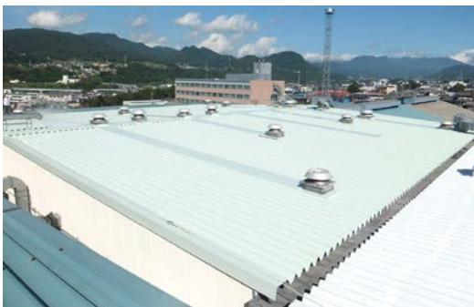
屋根の断熱塗装に用いた塗料は、太陽光反射率が高い着色顔料や熱放射率が高いセラミック、遮熱効果、塗装後の耐久性（耐候性）に優れた弱溶剤シリコン樹脂などの素材を組み合わせた多機能性遮熱塗料で、塗装を施した建屋内への熱の侵入を遮断することにより、空調設備の省エネを図ることができます。
