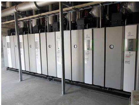
2014年度も、製造工程から出る排水・廃熱を回収して再利用する取り組みを精力的に進めました。たとえば、温排水を回収してボイラー向け給水として再利用することで、水やガスの使用量を削減でき、CO<sub>2</sub>排出量をさらに約60t-CO<sub>2</sub>減らすことができました。
