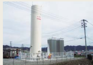
鴨川工場ガスタンク
