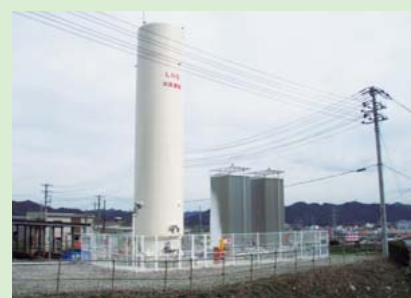
新設されたガスタンク
