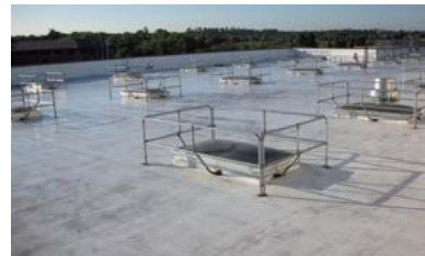
増設した施設に設置した天窓
