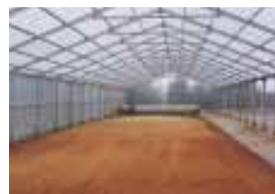
汚泥処理施設
