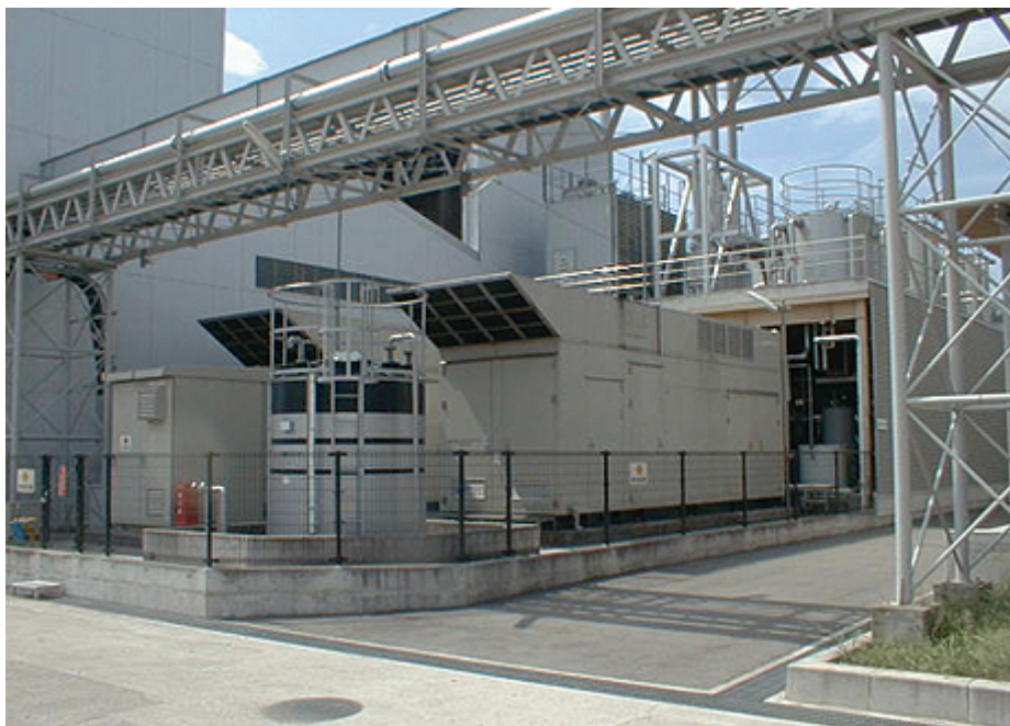
■ 高砂工場のコージェネレータ
