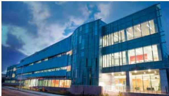
Laboratoriesの入居している建屋
