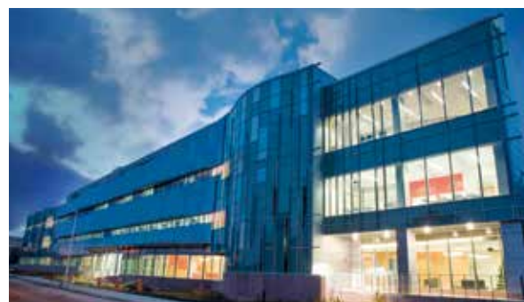
Laboratoriesの入居している建屋
