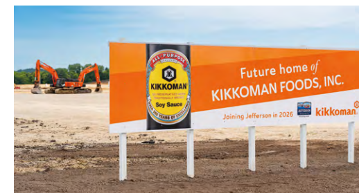
KFI新工場建設予定地
