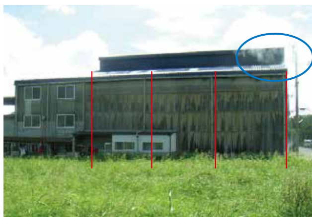
急造庫の外観
