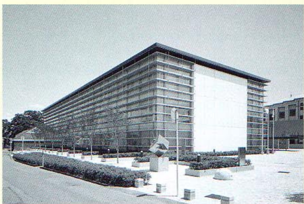
野田本社屋 事務棟(3階建)
