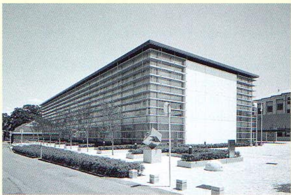
野田本社屋 事務棟(3階建)
