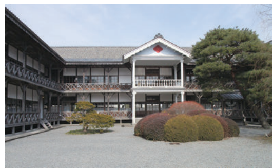
かつての繁栄の面影が残る旧登米高等尋常小学校校舎
