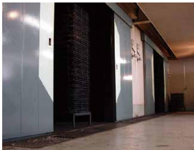
急造庫(大量生産用の焙乾装置)
